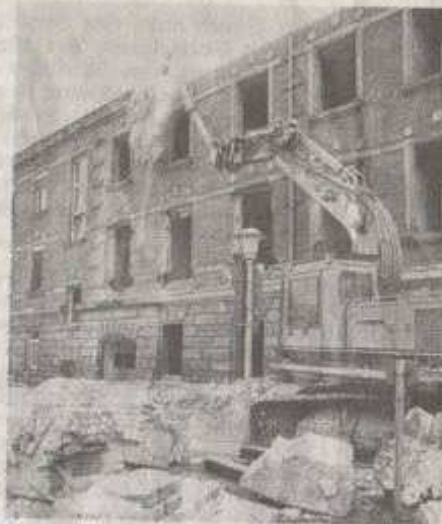
Der Anbau wird abgerissen – die ursprüngliche Bausubstanz bleibt.
